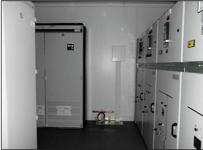
• 6,6kV Mittelspannungsanlage
